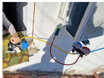
Slika 18. Vakumiranje sustava
