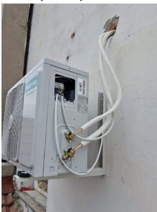
Slika 19. Spojena vanjska jedinica.
