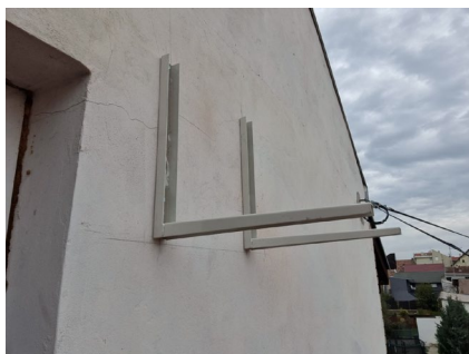
Slika 12. Nosači vanjske jedinice nasuprot unutarnje.
