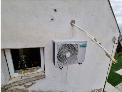
Slika 17. Montaža vanjske jedinice.
