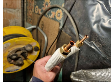
Slika 18. Pertlani spojevi vanjske jedinice
