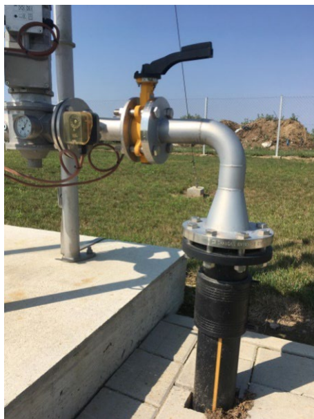
Slika 2. PEHD cjevovod na bioplinsko postrojenju „Hrastin“ [5]
