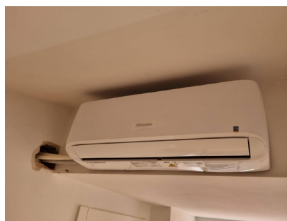
Slika 16. Montaža unutrašnje jedinice
