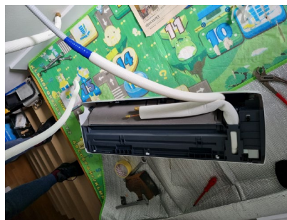
Slika 13. Spajanje crijeva za odvod kondenzata
