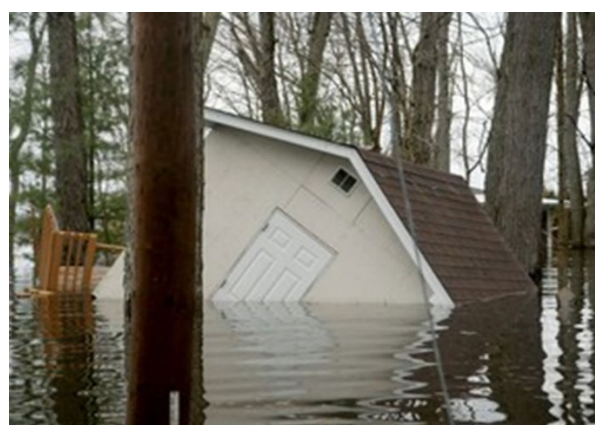
Slika 1: Utjecaj prevelikog uzgona na: grobnice, bazene, cjevovode, šahtove, razne spremnike, septičke jame, zaštitne bunke i stambene objekte, [11]
