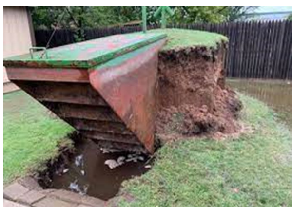
Slika 1: Utjecaj prevelikog uzgona na: grobnice, bazene, cjevovode, šahtove, razne spremnike, septičke jame, zaštitne bunke i stambene objekte, [11]
