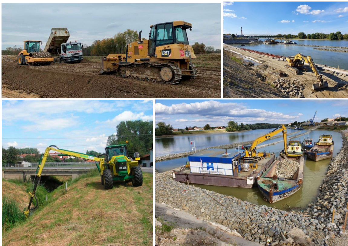
Slika 2. Rad strojeva na izvedbi i održavanju hidrotehničkih građevina [4] [5]
