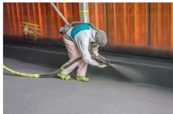
**Slika 4.** Ugradnja hidroizolacije Sikalastic 841ST špricanjem [5]
