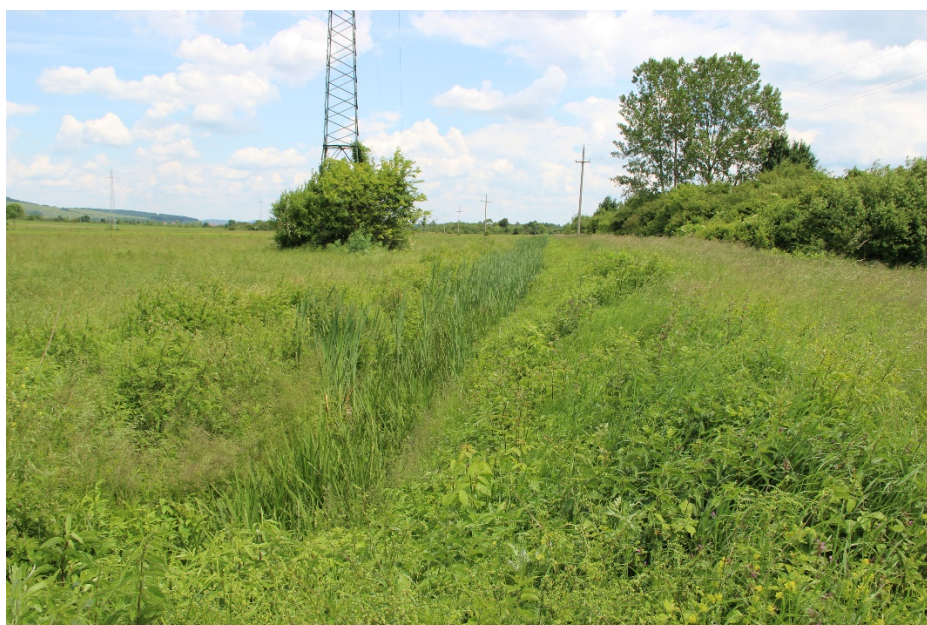
Slika 5: Stanje kanalske mreže u proljeće 2020. godine (fotografije iz arhive autora): korito skupljača Topolovca - pogled nizvodno; jedan detaljni kanal (K1) - pogled uzvodno
