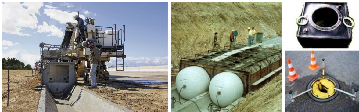
Slika 3. Horizontalno klizanje kanala (lijevo), primjena napuhane oplata za propuste (u sredini) i gumena oplata s metalnom jezgrom za kanalizacijska okna na cesti [8] (desno)
