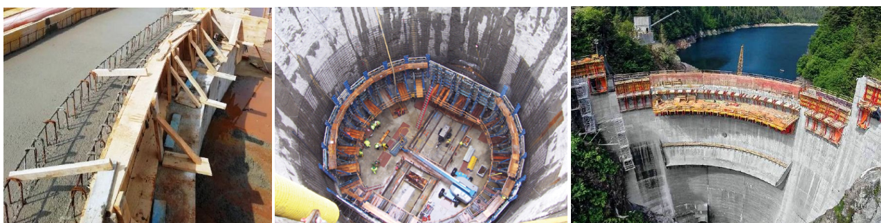
Slika 2. Tradicionalna oplata za betoniranje gornje ploče instalacijskog kanala velikog bazenskog kompleksa u Istri 2019. god. (lijevo), projekt vodovoda i kanalizacije ( The Big Pipe Water & Sewer Project ) u Portlandu izvođen 2009. god. s tvorničkim sustavom velikoplošnih oplata Doka [18] (u sredini) i podizanje visine brane na Blue Lake na Aljasci 2012. - 2015. god. pomoću Peri penjajuće oplata [19] (desno)
