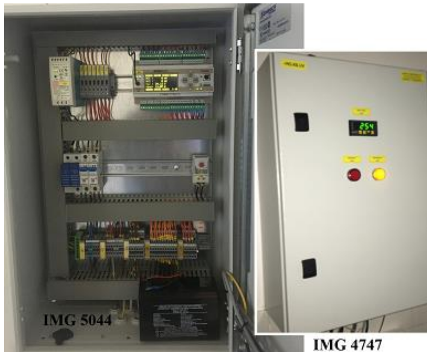
Slika 4. Elektroormarice IMG 5044 (pumpna stanica), i IMG 4747 (vodostan)
