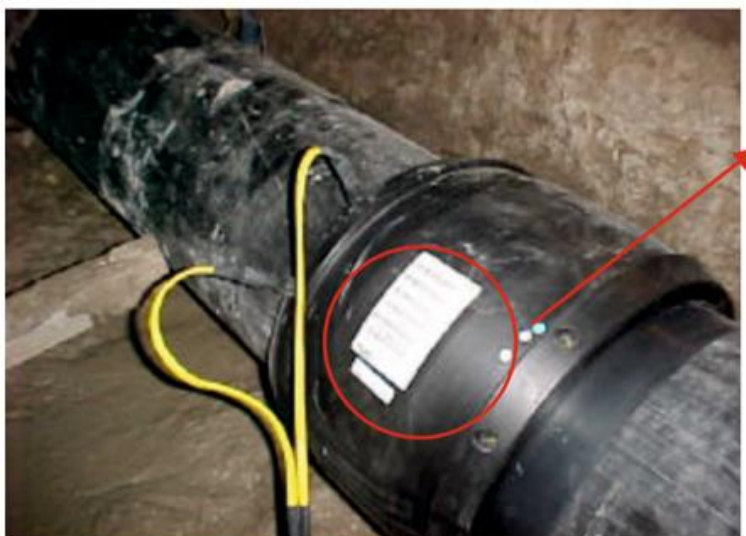
Slika 7. Priklučivanje spojnog elementa na elektrofuzijsku kontrolnu jedinicu [3]
