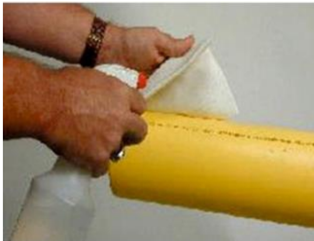
Slika 3. Čišćenje i odmaščivanje krajeva cijevi [3]
