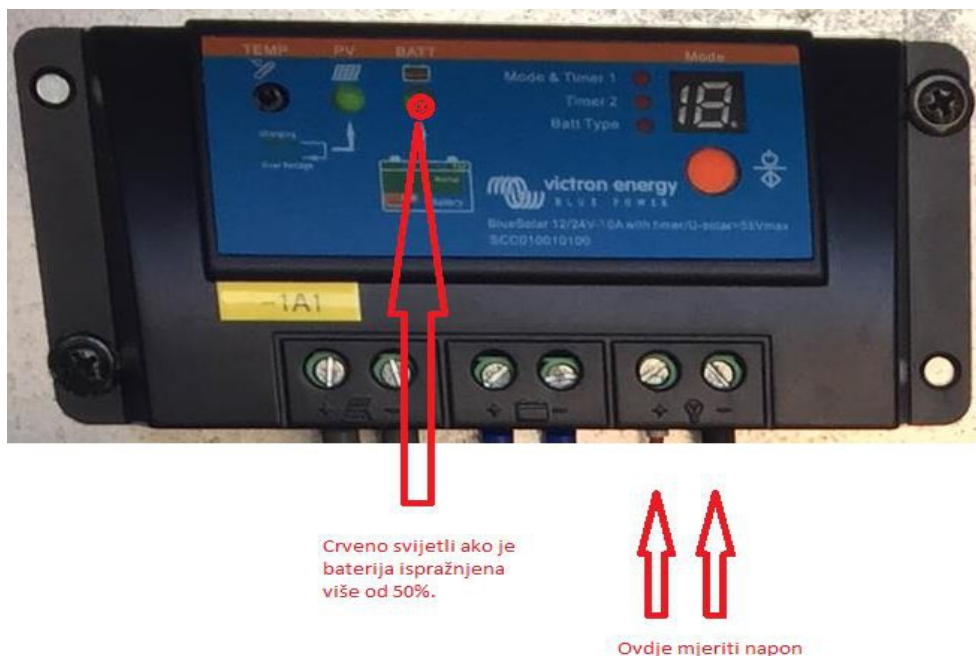
Slika 5. Kontrole nivoa baterije FN sistema
