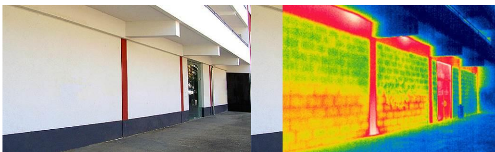
Slika 3. Primjeri konstrukcijskog toplinskog mosta [27]
