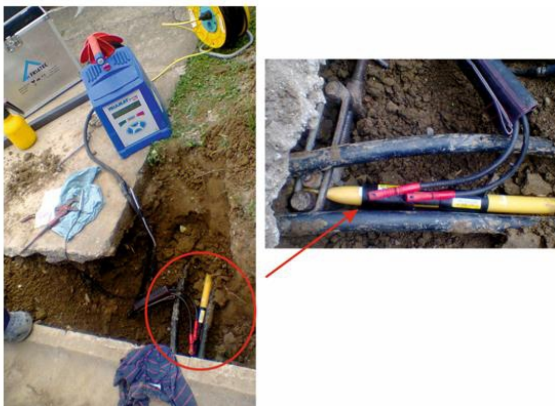
Slika 9. Elektrofuzijsko zavarivanje oštećene cijevi pri rekonstrukciji plinovoda
