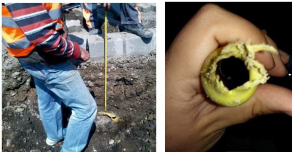
Slika 8. Mehanička oštećenja cijevi za distribuciju plina
