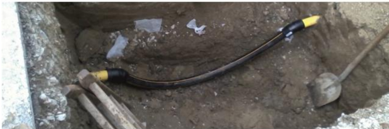
Slika 10. Reparirani dio plinovoda
