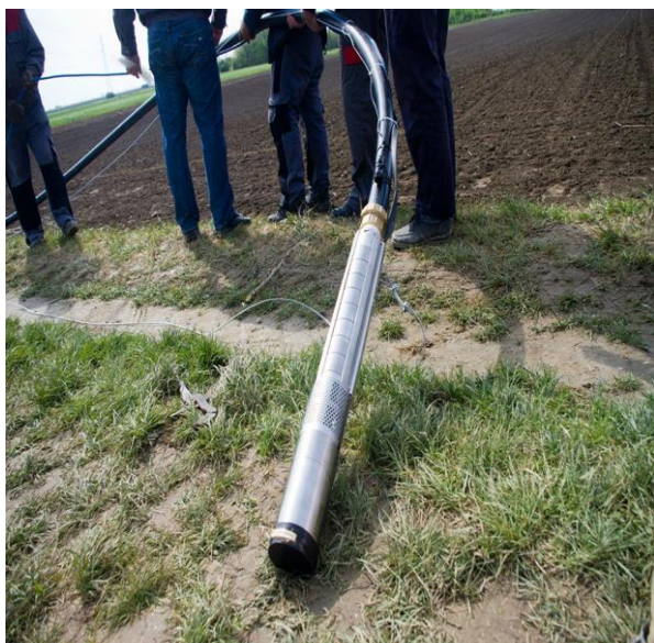
Slika 10. Električno povezana crpka i cijev Slika 11. Uvođenje cijevi i crpke u bušotinu
