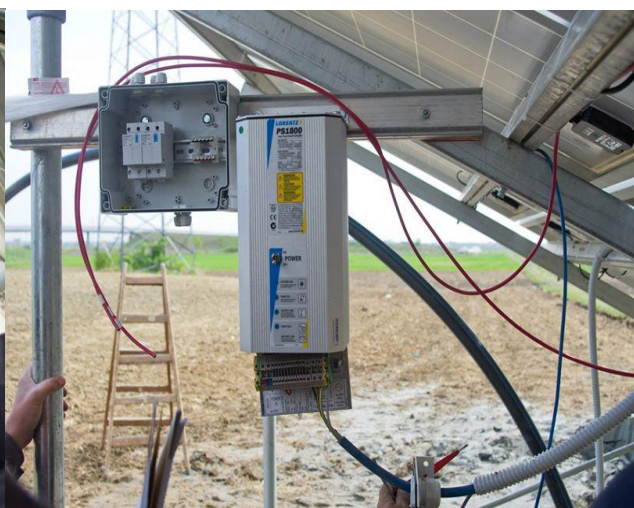
Slika 15. Ugradnja i ožičenje zaštitnih funkcija
