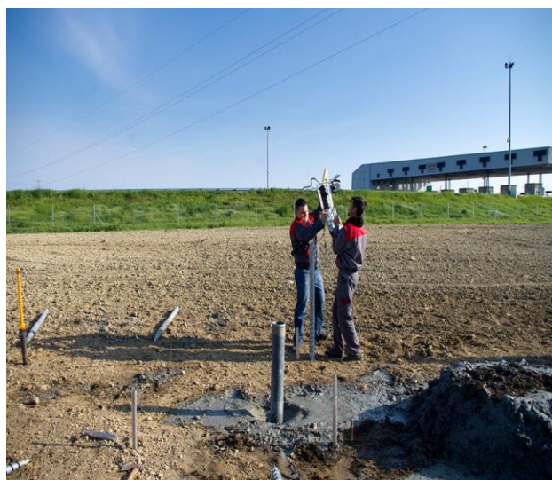
Slika 12. Montaža temelja FN sustava Krinner vijcima Slika 13. Ugradnja FN modula
