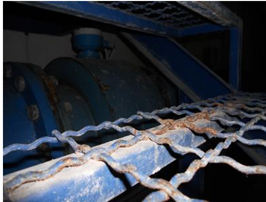
Slika 4. Oksidacijsko djelovanje u vlažnoj i agresivnoj sredini
