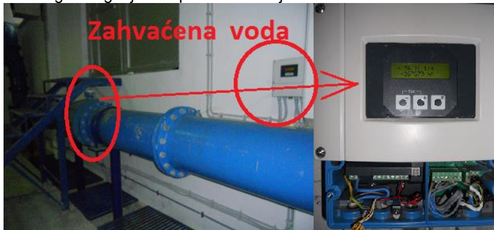
Slika 2. Elektromagnetni mjerač na liniji zahvaćene vode
