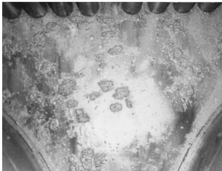
Slika 2. Primjer oštećenja cijevne stijene Steambloc kotla
