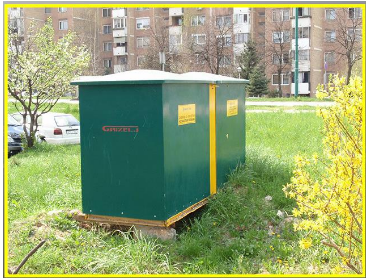
Slika 15. Smještaj plinske opreme u kućište sa jednim i sa dva otvora
