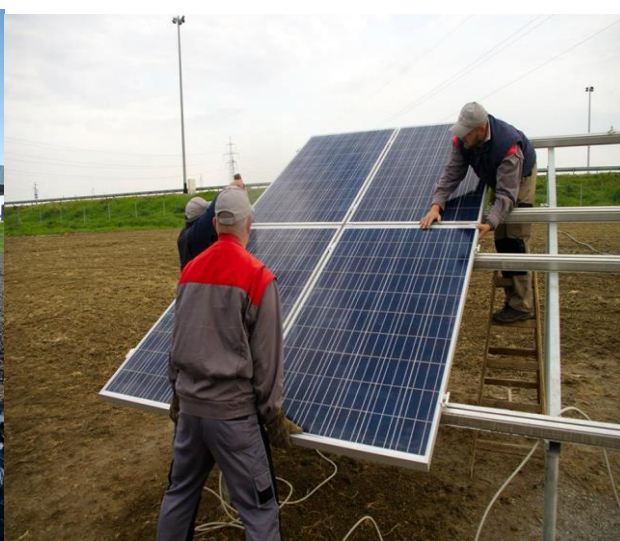
Slika 12. Montaža temelja FN sustava Krinner vijcima Slika 13. Ugradnja FN modula
