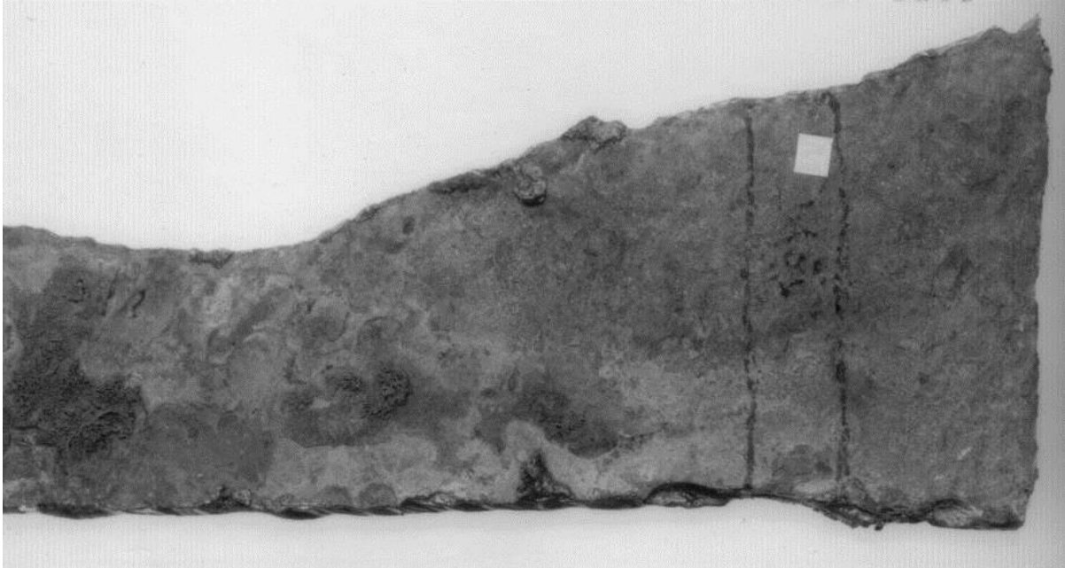
Slika 5. Poprečni presjek plašta kotla oštećenog korozijom
