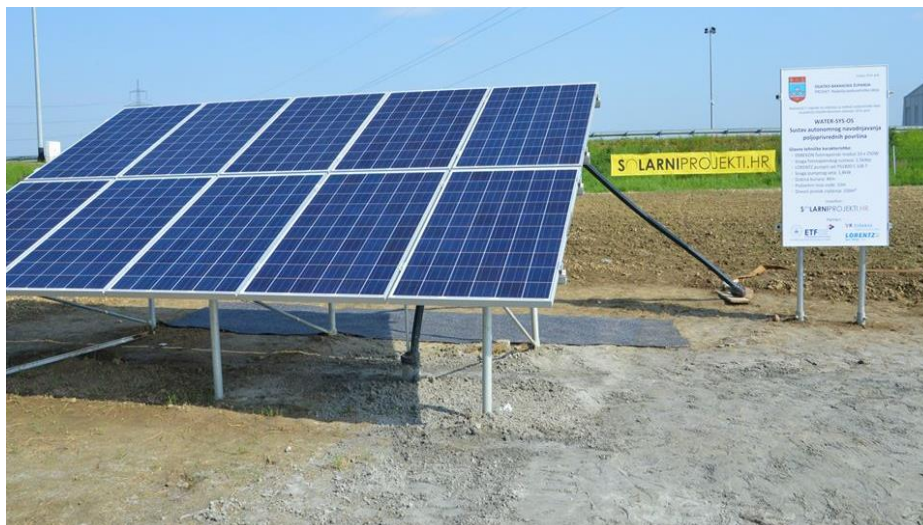
Slika 1. Fotonaponski sustav za autonomno navodnjavanje poljoprivrednih površina
