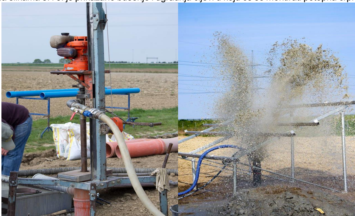
Slika 8. Bušenje cijevi za ugradnju crpke Slika 9. Čišćenje cijevi bušotine pod tlakom
