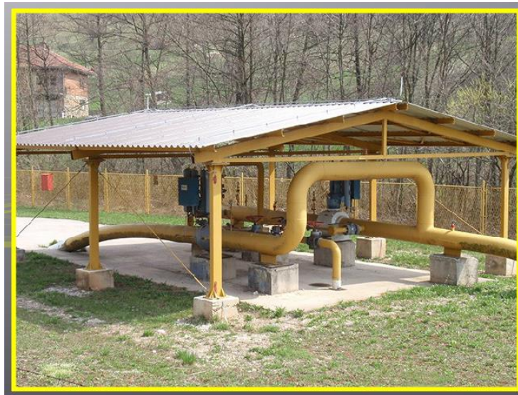
Slika 16. Smještaj plinske opreme na otvorenom
