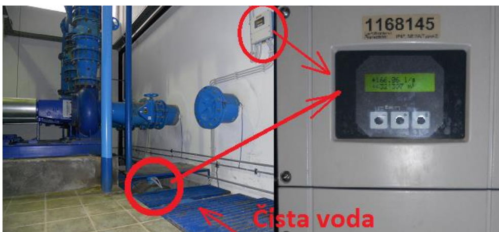
Slika 1. Položaj mjerača i rezultati mjerenja na liniji čiste vode
