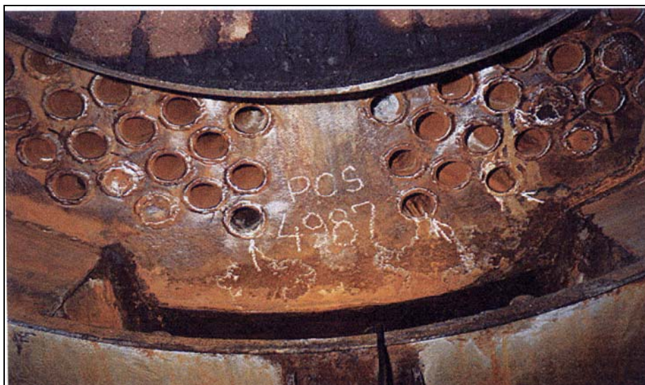
Slika 2.7. Izgled donjeg dijela prednje cijevne stijene (vidljivo – tragovi curenja, čepljene dimne cijevi i korozijska oštećenja) [1]
