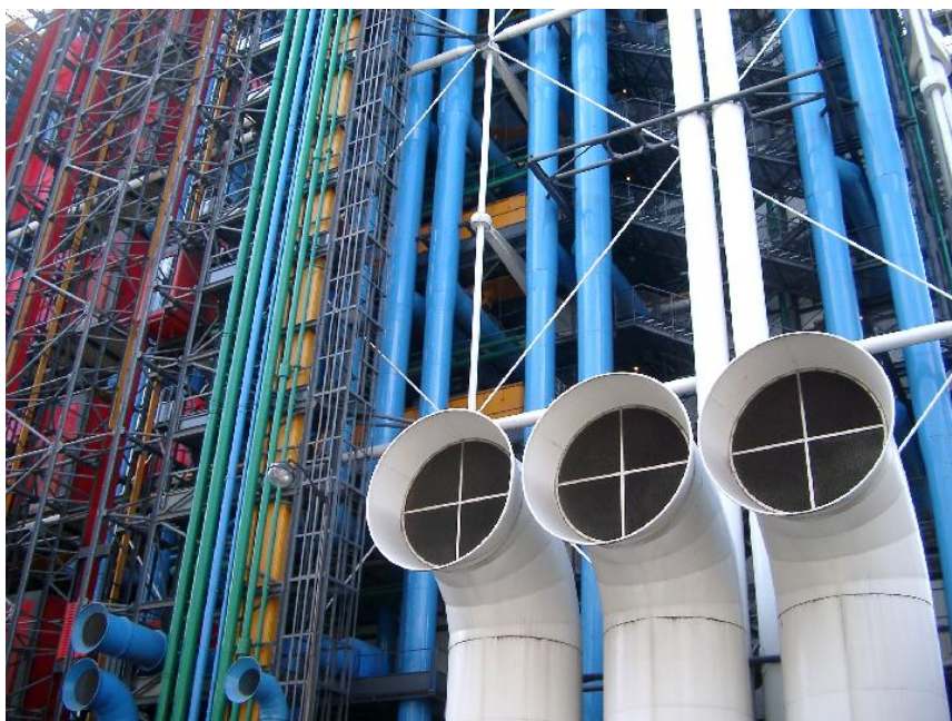
Slika 4. Centre Georges Pompidou – detalji i kolorit vanjskih instalacija (izvor: http://photoeverywhere.co.uk )
