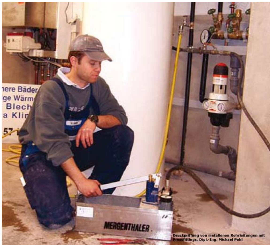
Slika 2. Ispitivanje sa vodom, [8]
