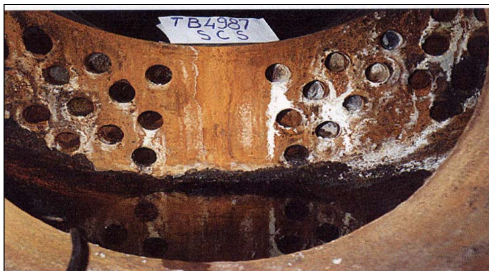
Slika 2.3 Izgled stražnje cijevne stijene u donjem dijelu kotla [1]
