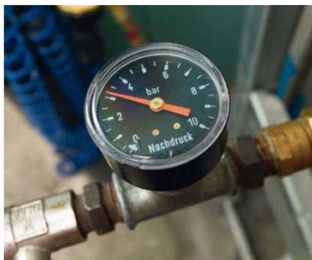
Belastungsprüfung mit Druckluft 3 bar.
