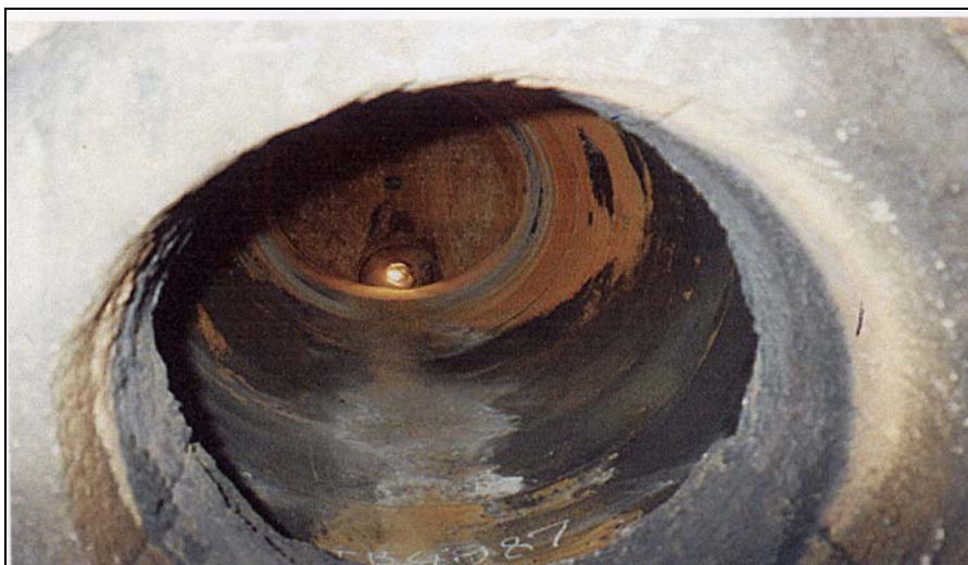
Slika 1.2 Izgled plamenice – pogled od prednje cijevne stijene
