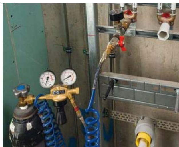
Praktisches Beispiel einer Dichtheitsprüfung mit Inertgas.
