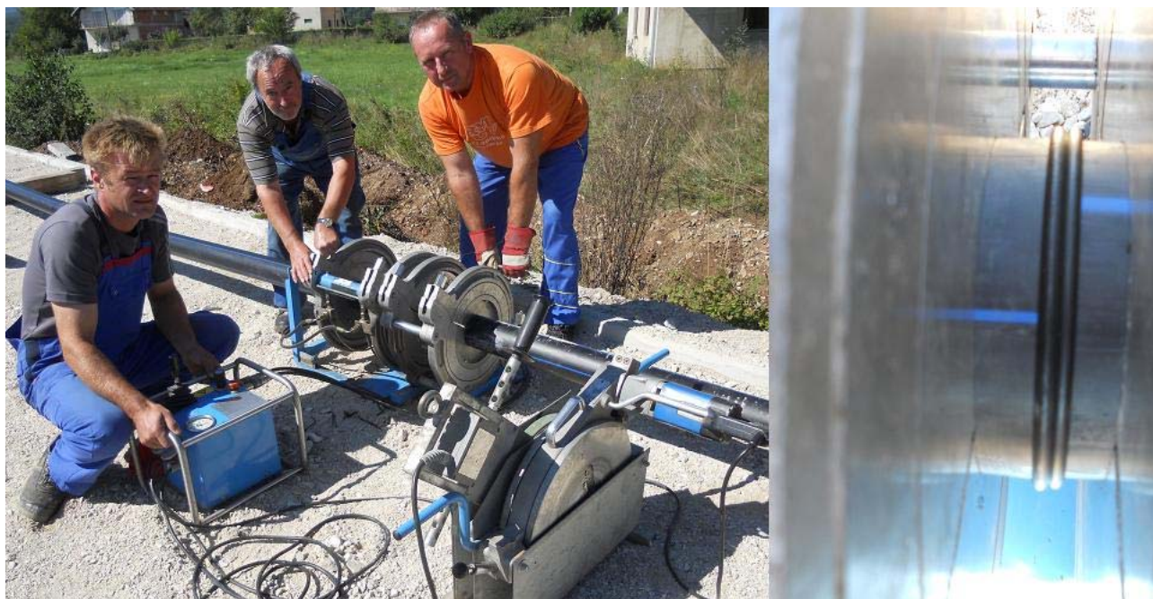
Slika 1. Sučeono varenje PE cijevi u JKP „ViK“ Sanski Most
