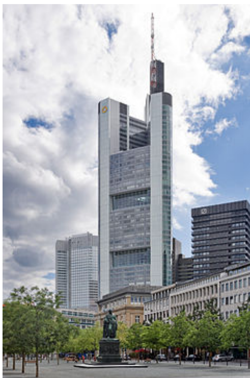
Slika 9. Commerzbank – 300 m visoka uredska zgrada (izvor: www.greatbuildings.com )
