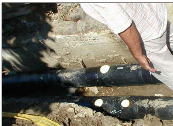
Slika 3 Vizualna kontrola ulijevanja poliuretanske smjese [1]
