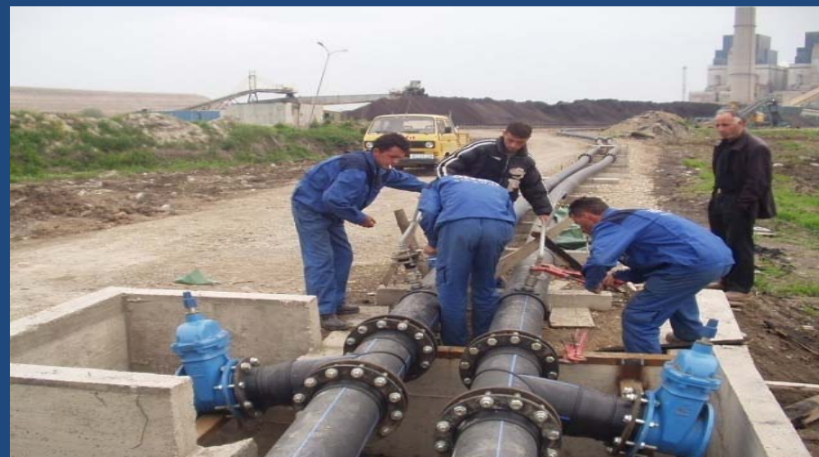
Slika 8. Montaža cjevovoda
