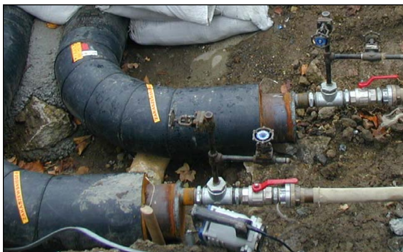
Slika 6 Izvođenje tlačne probe [1]
