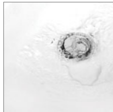
zbrinjavanje otpadnih voda
