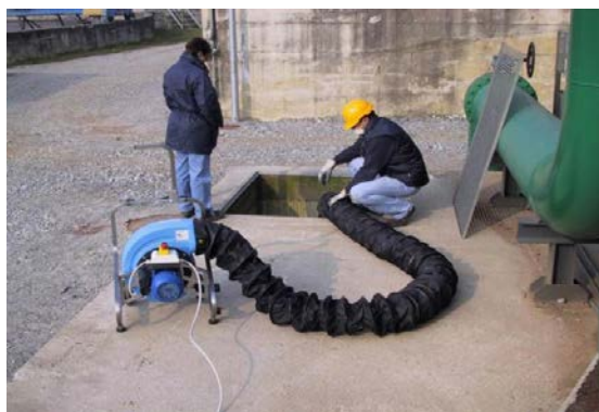
Slika 4. Zavarivanje u ograničenom prostoru (1- prijenosni ventilacijski agregat, 2 - promatrači koji nadziru, 3 - izvor napajanja, 4 - rasvjetna lampa, 5 - spasilačko uže, 6 - zavarivač) [17]
