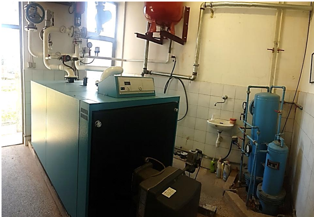
Slika 10. Plinski kotao u kotlovnici zgrade SFSB-a
