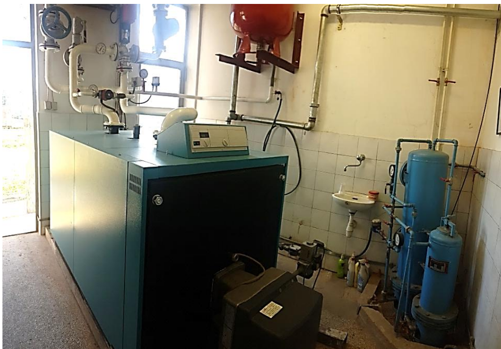
Slika 10. Plinski kotao u kotlovnici zgrade SFSB-a
